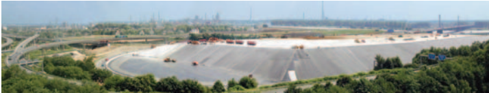
Der Bereich innerhalb des Autobahnkreuzes Leverkusen-West wird großflächig mit Kunststoffdichtungsbahnen (Flachbereiche) und Asphalt (Böschungen) abgedichtet.
